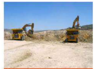
EXCAVACIONES Y MOVIMIENTOS DE TIERRAS
